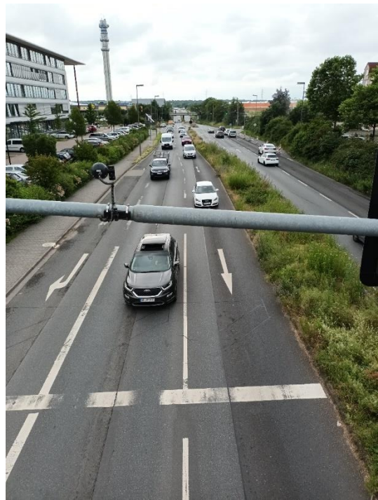
Verkehrskamera auf Ampelausleger
