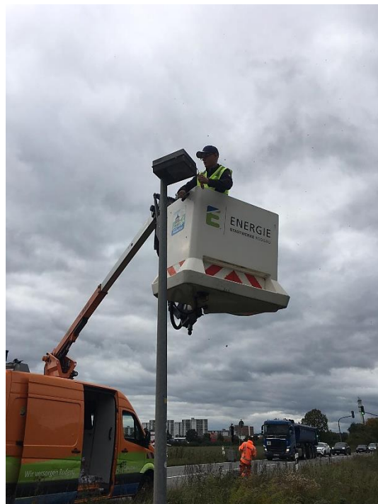
Leuchtentausch in Dietzenbach
