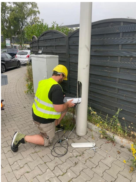
Einbau LoRaWAN Gateway in Lichtmast
